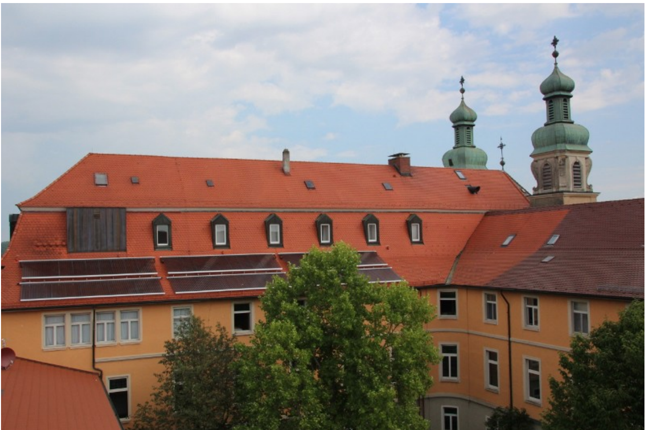
Abb. 1: Blick auf das Kollektorfeld der Solarthermieanlage an der Südfassade des Klosters
